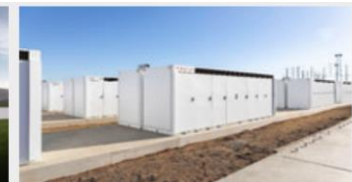
施工例：オーストラリアのビクトリア州ジーロングに建設中の300MW/450MWhのメガパックシステム。
