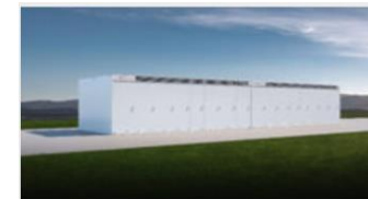
施工例：アメリカのカリフォルニア州モスランディングに建設中の世界最大級の182MW/730MWhのメガパックシステム
