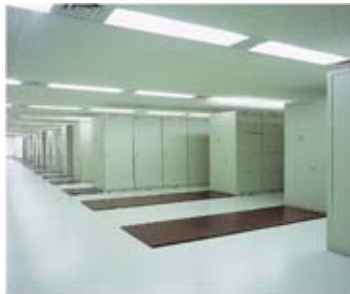
バックオフィス (データセンター)
